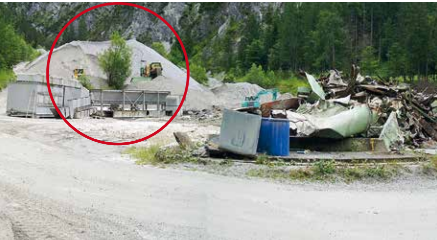
Der Rückbau begann mit dem Abbau der Anlagen und wurde mit der Abfuhr der Asphaltrückstände abgeschlossen.
