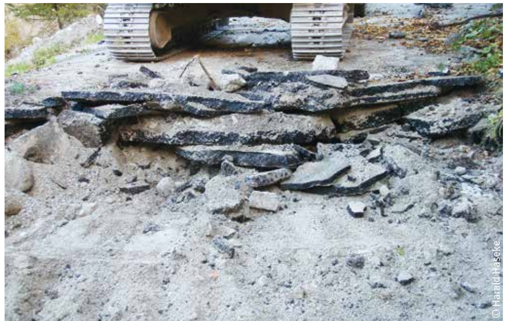
Der Rückbau begann mit dem Abbau der Anlagen und wurde mit der Abfuhr der Asphaltrückstände abgeschlossen.
