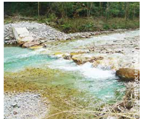
Eine neue Betongrundschnelle nach der Umsetzung – kein Hindernis mehr für Fische bei der Wanderung
