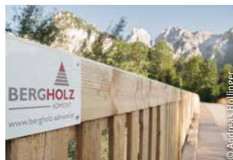
Die neu errichtete Lauferbauerbrücke aus Lärchenholz
