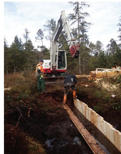
Die Höhendifferenz zwischen zwei Bauwerken sollte 20 cm (30 cm) nicht überschreiten, damit eine möglichst optimale Wiedervernässung auf der Fläche ermöglicht wird. Die Lage der Staus wurde mittels Höhenmodell bereits im Oktober 2018 ermittelt. Im Gelände wurden diese geplanten Staus verortet und markiert sowie je nach Situation während der Umsetzung angepasst, etwa wenn Gehölze den Einbau an einer Stelle erschwerten.
