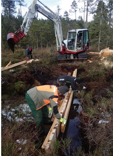
Abb. 10: Zur Stabilisierung des fertigen Bauwerkes werden abschließend oben Querbretter angebracht. Meist hat sich oberhalb der Spundwand bereits Wasser gestaut, während die Arbeiter, die jetzt nur noch die Querbretter mit Schrauben fixieren müssen, unterhalb noch im Trockenen stehen (Stau 8.6, 22.11.2019).
