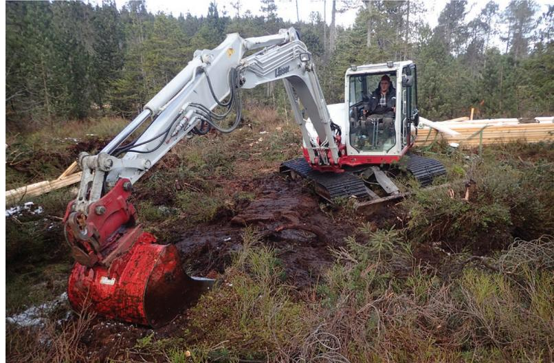
Abb. 11: Dritter Schritt: Schließlich wird das Bauwerk mit dem ausgehobenen Torf und der abgezogenen Vegetationsschicht abgedeckt (Stau 8.6, 22.11.2019).
