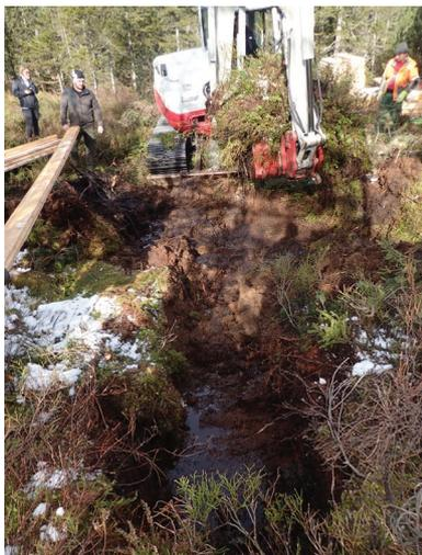
Abb. 8: Erster Schritt bei der Erstellung eines Grabenstaus: Quer zum bestehenden Graben wird mit einem Moorbagger die obere Vegetationsschicht abgezogen und bis in die intakte Torfschicht ausgeschachtet. Wurzelwerk oder im Torf querliegendes Holz wären Hindernisse beim Einbauen der Spundwand. Der Aushub wird zwischendeponiert (Stau 8.6, 22.11.2019).
