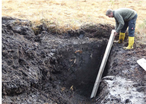
Abb. 6 und 7: Quer zum Graben wurde ein Schacht in der Länge des Stauwehres ausgehoben. Die oberste Torfschicht samt Vegetation wurde in »Torfziegel« abgehoben und zur späteren Abdeckung des Bauwerks zur Seite gelegt (Foto: Georg Amann). Danach wurde der Schacht ausgehoben, bis die Grabensohle erreicht war (Foto: Anne Puchta).
