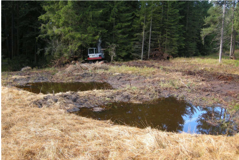
Abb. 42: Neu errichtete Tümpel an Graben 3 unmittelbar nach der Umsetzung. Die Torflöcher haben sich noch nicht vollständig mit Wasser gefüllt. Im Bereich der eingebauten Spundwände entstehen durch Torfüberdeckung erhöhte Torfwälle und am Rand bleiben durch die Baggerarbeiten mehr oder weniger offene nicht überschwemmte Torfböden. 07.11.2013. (Foto: Georg Amann).
