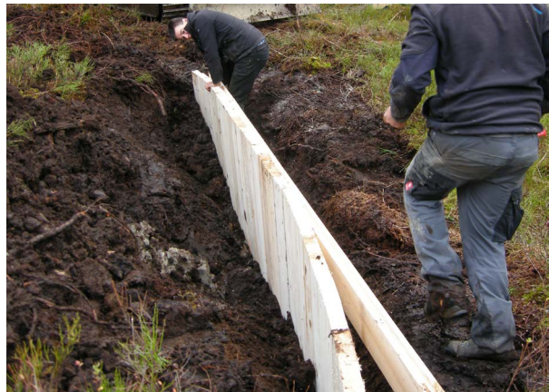
Abb. 8 und 9: Mit dem Bagger wurden die Spundbretter in den Boden gedrückt. Zur Erhöhung der Wasserdichtheit und zur sicheren Führung der Bretter waren diese mit Nut und Kamm versehen. Das untere Ende der Bretter war in einem spitzen Winkel abgesägt, damit sie beim Einrammen durch den Bodendruck gegen das benachbarte Spundbrett gedrückt wurden (Foto: Anne Puchta). Die Länge der Spundwand bzw. die Breite des Stauwehres beträgt 3-3,5 m, damit das Wasser nicht nur am Graben aufgestaut, sondern auch seitlich möglichst weit in die Moorfläche geleitet wird. Die Spundbretter wurden mit einer Querdiele verschraubt (Foto: Georg Amann).
