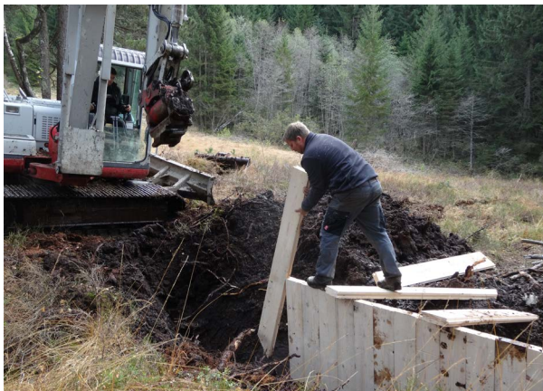
Abb. 8 und 9: Mit dem Bagger wurden die Spundbretter in den Boden gedrückt. Zur Erhöhung der Wasserdichtheit und zur sicheren Führung der Bretter waren diese mit Nut und Kamm versehen. Das untere Ende der Bretter war in einem spitzen Winkel abgesägt, damit sie beim Einrammen durch den Bodendruck gegen das benachbarte Spundbrett gedrückt wurden (Foto: Anne Puchta). Die Länge der Spundwand bzw. die Breite des Stauwehres beträgt 3-3,5 m, damit das Wasser nicht nur am Graben aufgestaut, sondern auch seitlich möglichst weit in die Moorfläche geleitet wird. Die Spundbretter wurden mit einer Querdiele verschraubt (Foto: Georg Amann).
