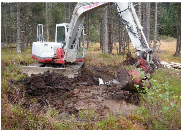
Abb. 10 und 11: Der Bauschacht wurde verfüllt und die Holzspundwände wurden mit dem anfallenden Aushubmaterial (Torf) abgedeckt und angebösch, um sie vor Witterungseinflüssen und Verrottung zu schützen. Zuletzt wurden die vegetationsfreien Stellen auf den Staus mit den zwischengelagerten »Torfziegel« abgedeckt. Oberhalb der Staus verblieben Mulden größtenteils ohne Vegetationsabdeckung, die sich bald mit Wasser füllten. Als Nebeneffekt der Hochmoorrenaturierung entstanden neue Kleingewässer (vgl. Abb. 42) (Fotos: Georg Amann).
