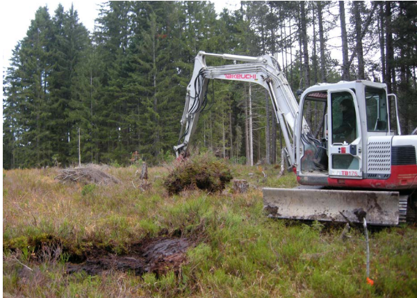
Abb. 6 und 7: Quer zum Graben wurde ein Schacht in der Länge des Stauwehres ausgehoben. Die oberste Torfschicht samt Vegetation wurde in »Torfziegel« abgehoben und zur späteren Abdeckung des Bauwerks zur Seite gelegt (Foto: Georg Amann). Danach wurde der Schacht ausgehoben, bis die Grabensohle erreicht war (Foto: Anne Puchta).
