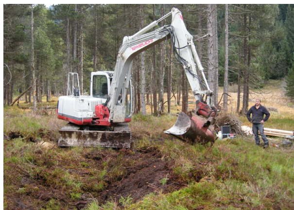
Abb. 10 und 11: Der Bauschacht wurde verfüllt und die Holzspundwände wurden mit dem anfallenden Aushubmaterial (Torf) abgedeckt und angebösch, um sie vor Witterungseinflüssen und Verrottung zu schützen. Zuletzt wurden die vegetationsfreien Stellen auf den Staus mit den zwischengelagerten »Torfziegel« abgedeckt. Oberhalb der Staus verblieben Mulden größtenteils ohne Vegetationsabdeckung, die sich bald mit Wasser füllten. Als Nebeneffekt der Hochmoorrenaturierung entstanden neue Kleingewässer (vgl. Abb. 42) (Fotos: Georg Amann).
