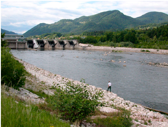
Abbildung 27: Bestehendes Kraftwerk bei Vrhovo
