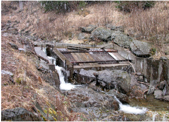
Abbildung 23: Wasserfassung des KW Brunner am Saureggengbach mit Fischaufstiegshilfe
