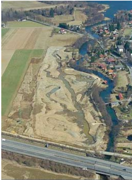
Foto 18: Laichschongebiet März 2000, nach Fertigstellung. Foto: J. Petutschnig
