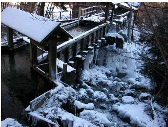
Foto 14: Aufstiegshindernis im Bereich der Tieselquelle. Foto: KIS
