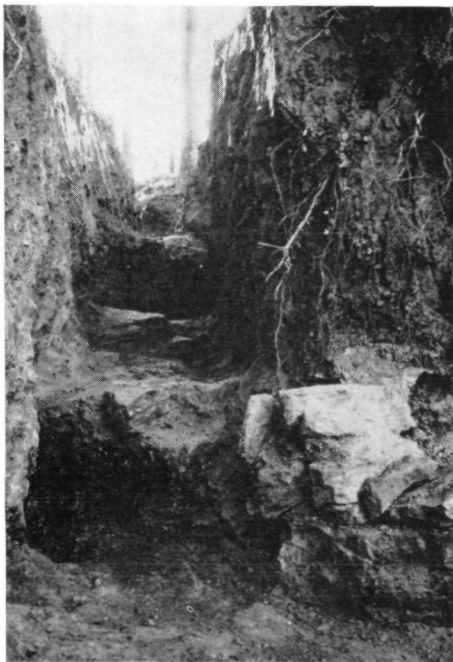
Abb. 7. Steinbach. Die mächtigen Steinfundamente der ma. Anlage (zu S. 224)
