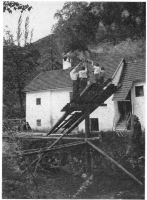
Abb. 9. Pilotenschlagen in Schmiegleiten, 1936
