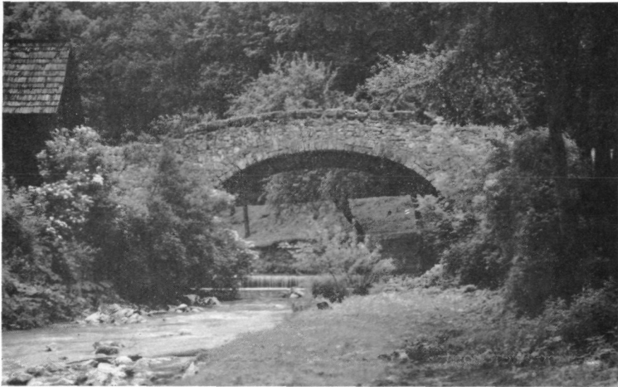
Abb. 2. Die Bogenbrücke im Zug der alten Landstraße
