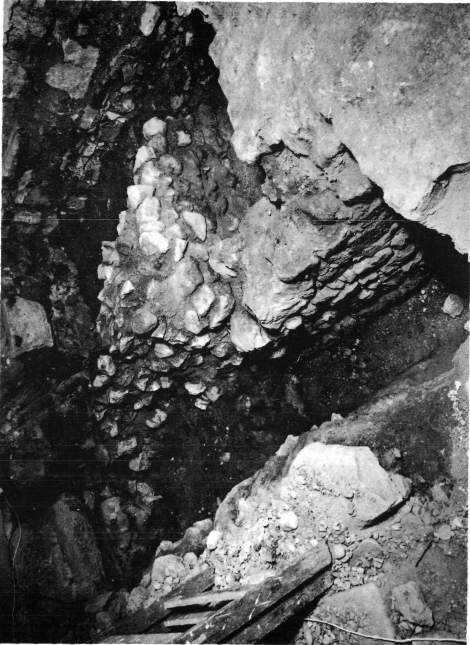
Abb. 1 Pfarr-(Stifts-)Kirche Mondsee, "Benedictus-Kapelle", Ostteil, Grabungsbefund gegen Südosten (vorne Mauer B, durchgeschlagen vom Mauerkreuz C, dessen Ost-West-Mauer unter der Türöffnung der Kapelle nach Osten zieht (zu Seite 65 ff).
