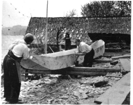
Abb. 18. Ausarbeiten („Putzen“) des „Prügels“.
