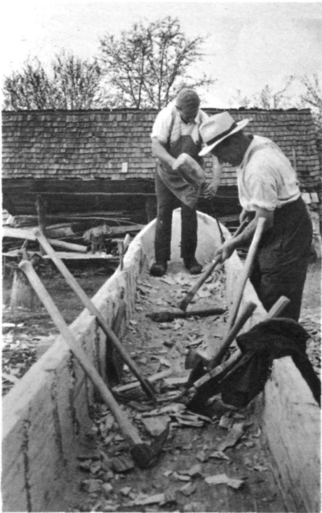
Abb. 17. Ausarbeiten („Putzen“) des „Prügels“.
