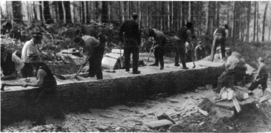
Abb. 7 Einhacken in der Längsrichtung zum Entfernen des Überholzes.
