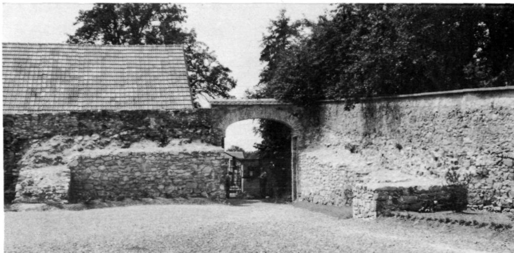
Abb. 1: Wieselburg a. d. E., Kirchberg, Bruchsteinmauern des Innenturmes.
