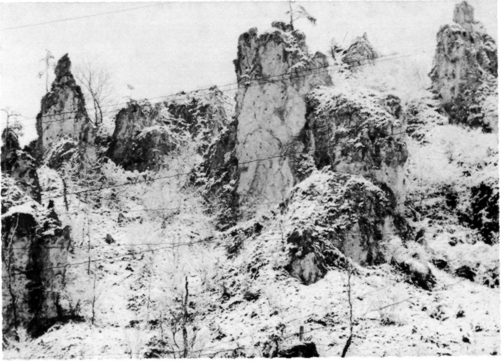
Abb. 1: Die Felsstürme (Dolomit) am rechten Ennsufer oberhalb KW Schönau.
