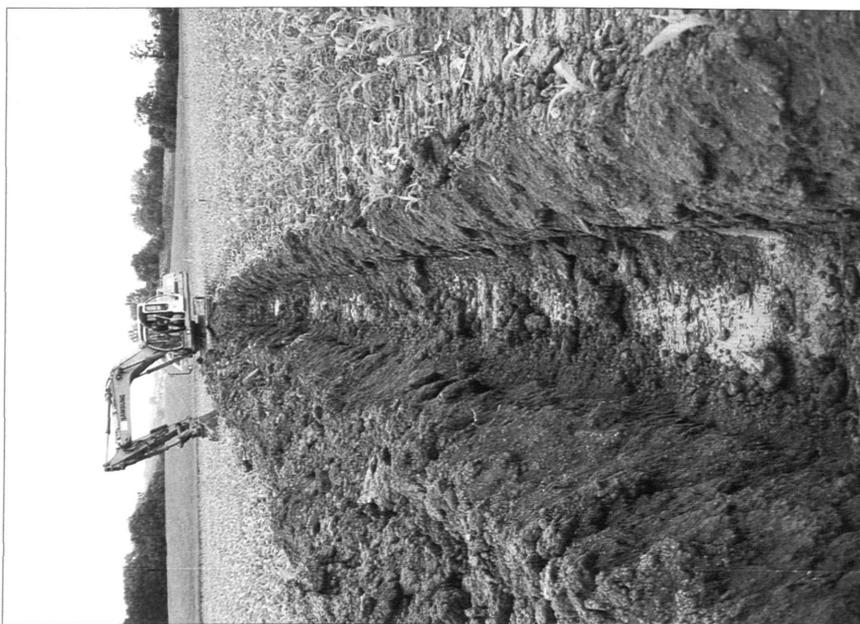
Abb. 3: Ausheben von Suchschnitten mit dem Bagger
