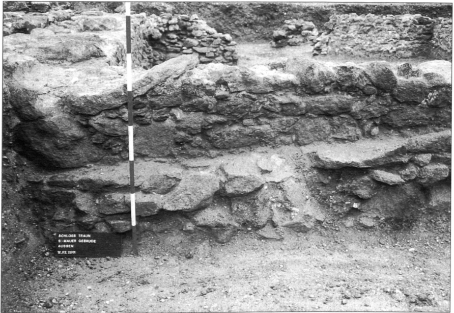
Abb. 2: Abgesunkenes Fundament der Südmauer des Gebäudes, darüber die schmälere Ausbesserung.
