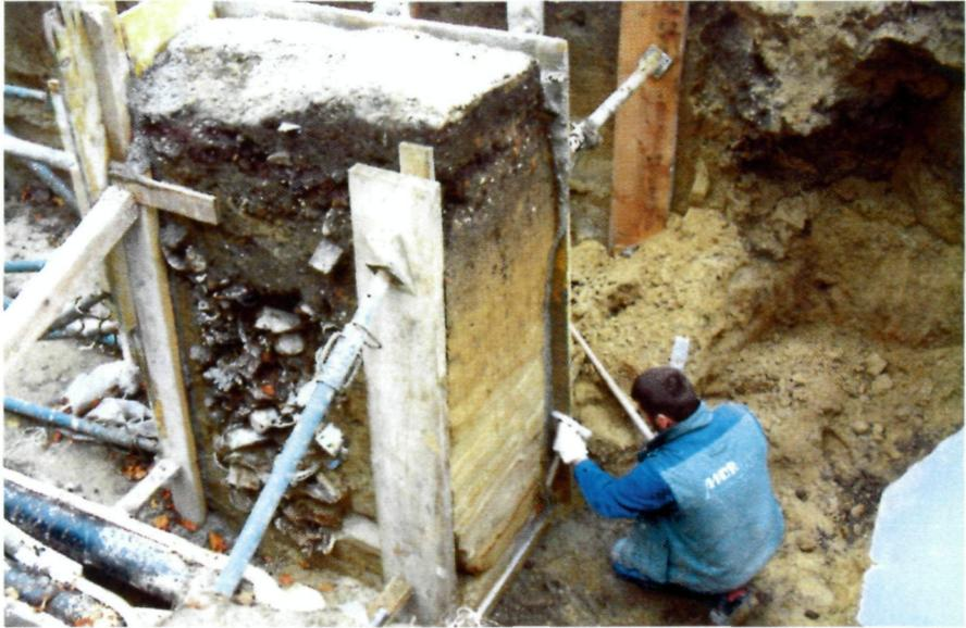
Abb. 9: Am bereits freigegrabenen Block wird die nördliche Seitenfläche abgearbeitet, um die Stahlplatte anpassen zu können. (Foto: W. Klimesch)
