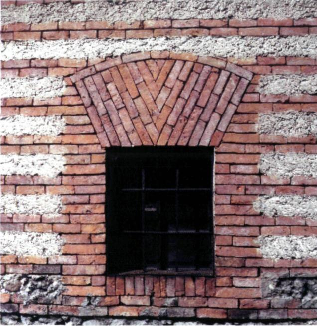
7 Fenster im Schichtenmauerwerk mit scheinrechtem Sturz, voll ausgemauert, aus Hofkirchen bei St. Valentin (NÖ)
