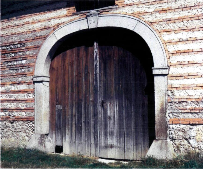
9 Einfahrt im Schichtenmauerwerk mit Gewände aus Werkstein, datiert 1860, aus Hofkirchen bei St. Valentin (NÖ)
