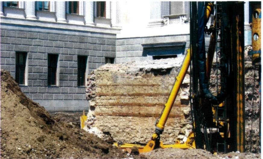
12 Schichtenmauerwerk unterhalb der Rampe des 1873-1883 erbauten Parlamentsgebäudes in Wien, freigelegt und teilweise abgetragen 2004
