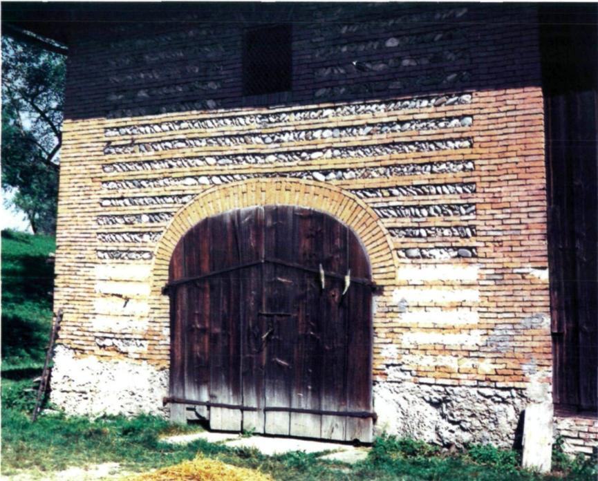
10 Einfahrt im Schichtenmauerwerk mit gemauertem Bogen und gemauertem Gewände, aus Hofkirchen bei St. Valentin (NÖ)
