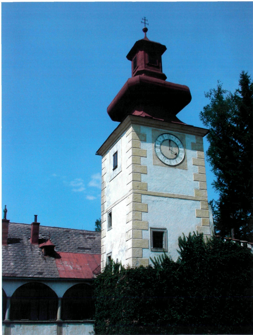
Hofansicht des zentralen Stiegenturms
