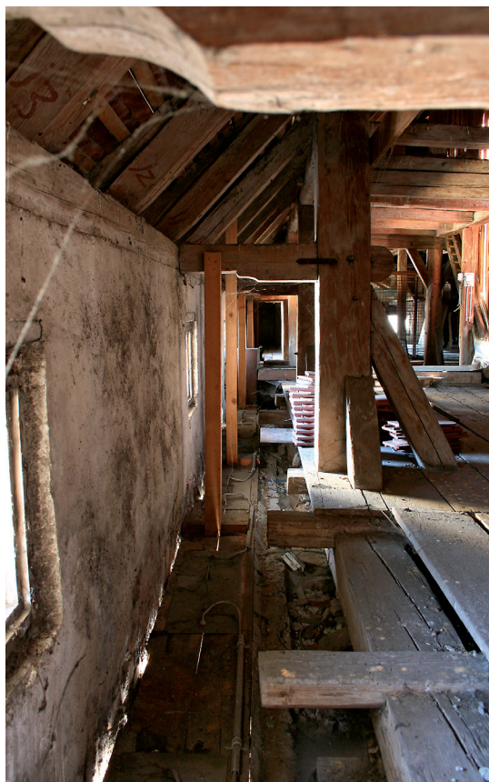
Abb.11: Maschikulizone (abgedeckt) im Dachboden. Foto: Verfasser.
