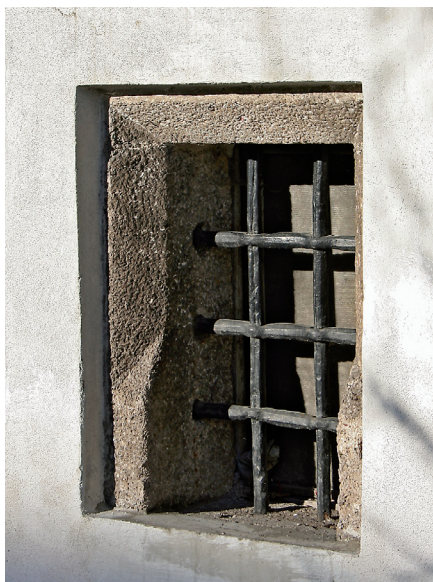
Abb.1: Hauptfassade, äußerstes Parterrefenster rechts. Foto: Verfasser.
