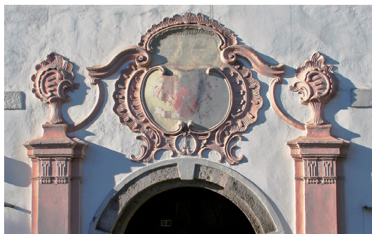
Abb.19: Portalrahmen, ca. 1770. Foto: Verfasser.
