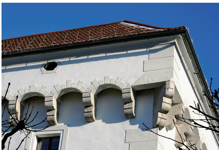
Abb.9: Kranzgesimse, Detail. Foto: Verfasser.
