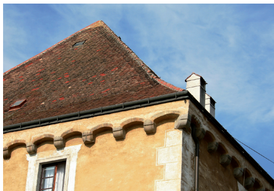
Abb.12: Pragstein (Mauthausen), Konsolenkranz, Detail. Foto: Verfasser.
