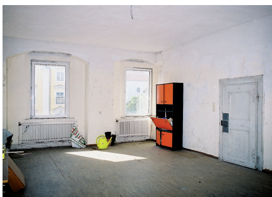
Abb. 10: Raum 2.04, Blick Richtung Südwesten.
