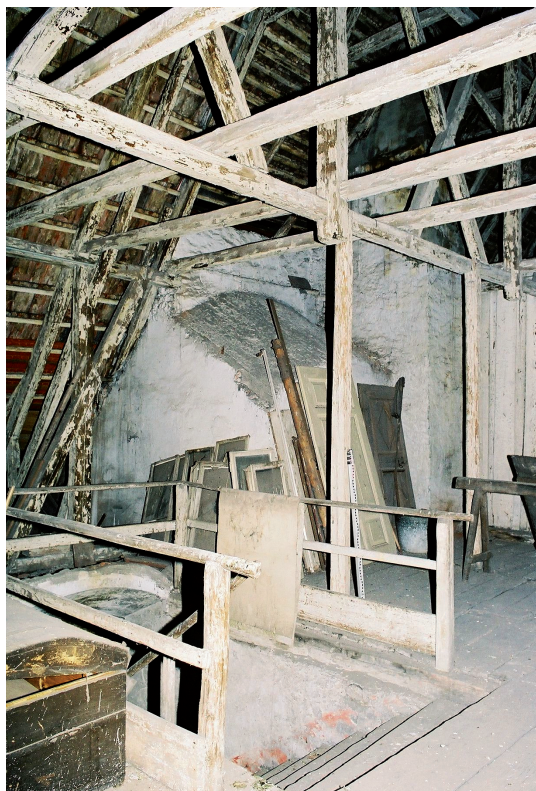
Abb. 4: Dachgeschoß, rechts vom Stiegenaufgang aus dem 2.OG ist der nördliche Lichtschacht erkennbar, vgl. Abb. 8 und 9.
