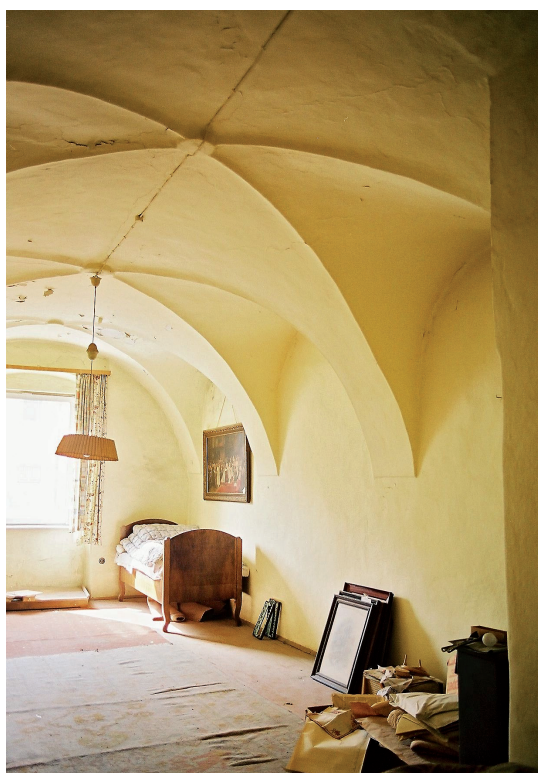
Abb. 9: Raum 2.03, Blick Richtung Südwesten.
