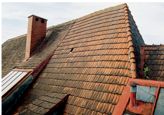
Abb. 8: Blick Richtung Westen auf das südliche Satteldach des Hauptgebäudes, links der südliche Lichtschacht neben dem Kamin, rechts unten der nördliche Lichtschacht und der niedrigere First des nördlichen Satteldaches.
