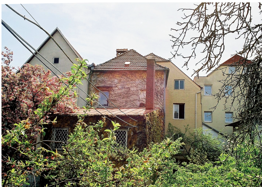
Abb. 2: Blick auf die Hoffassaden; das relativ flach geneigte Dach mit Schopfwalm über dem nördlichen Teil des Hauptgebäudes wurde zugleich mit der Aufstockung des links anschließenden Hofgebäudes um 1800 errichtet.
