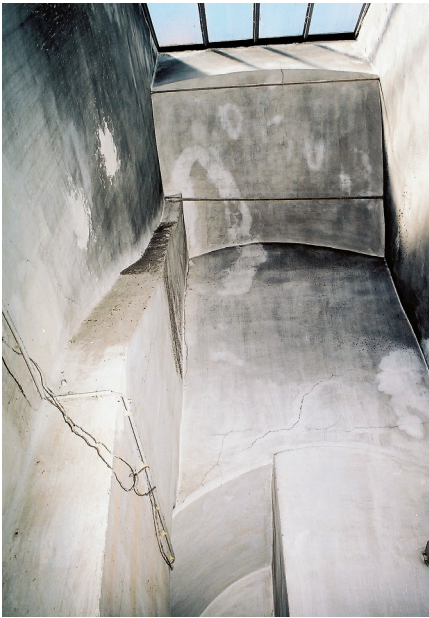
Abb. 11: Raum 2.07, Blick Richtung Westen, Lichtschacht mit Kamin.
