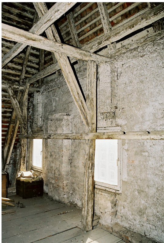
Abb. 5: Dachgeschoß, Giebelwand zum Stadtplatz mit Halbwalm, davor der Mittelständer zur Unterstützung des Unterzugs und der Diagonalstrebe des Längsverbandes.
