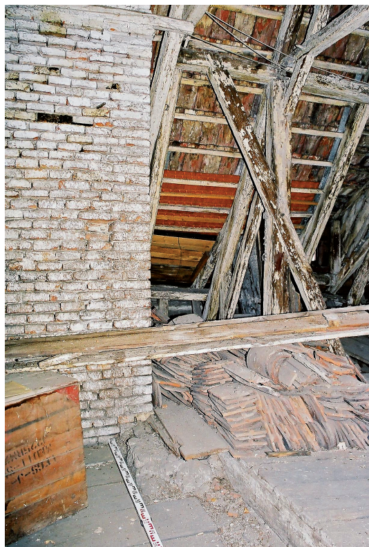
Abb. 6: Dachgeschoß, Blick Richtung Osten, unmittelbar vor dem nördlichen Lichtschacht. Rechts von der Messlatte erkennt man die in Ost-West-Richtung verlaufende Mauerkrone, die die hofseitige Fassade des spätmittelalterlichen Gebäudes markiert. Die etwa 60 cm starke Mauer besteht aus Bruch- und Findlingssteinen.
