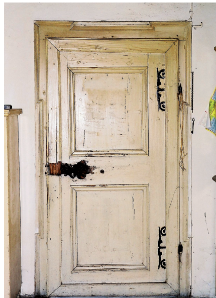
Abb. 14: Raum 2.11, Nordwand, barockes Türblatt mit Verkleidung am abgemauerten Durchgang in den Raum 2.13.
