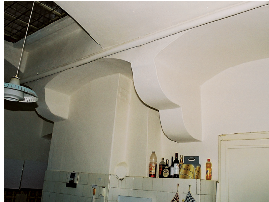
Abb. 12: Raum 1.06, Trennwand zu Raum 1.05 mit Kragsteinen.
