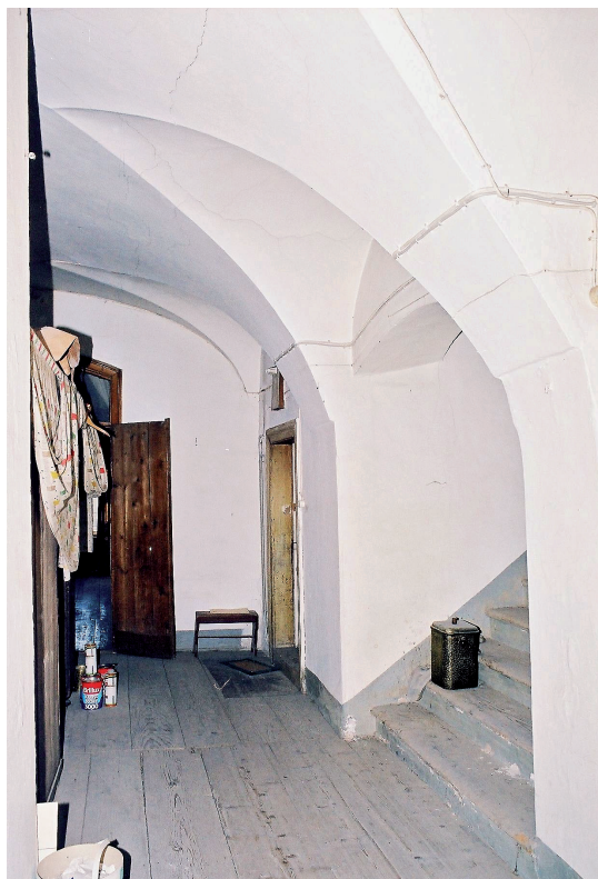
Abb. 3: Raum 2.02, das Stichkappengewölbe bezieht sich auf den Stiegenaufgang zum Dachboden.
