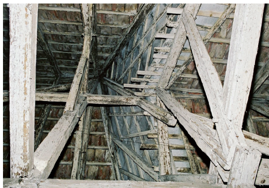
Abb. 7: Dachraum; Blick Richtung First am Übergang zwischen dem höheren südlichen (oben) und dem niedrigeren nördlichen (unten) Dach des Hauptgebäudes.
