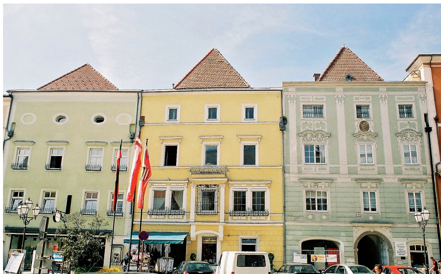
Abb. 1: Die Fassaden von Stadtplatz 46 bis 48 mit abgewalmten Satteldächern über den mit Vorschussmauern verbreiterten Giebelwänden.
