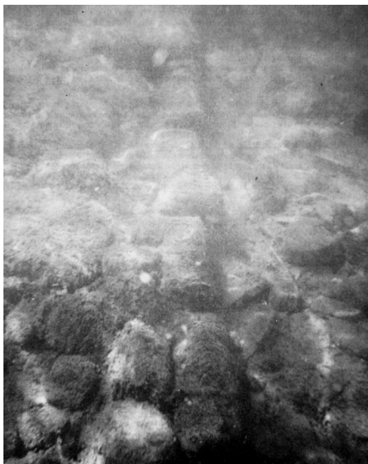
Abb. 16: Mole A im Uferbereich mit durchlaufender Bohlenreihe (vgl. Abb. 14) (Foto: J. Offenberger, 1976)
