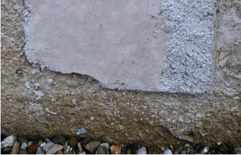
Abbildung 14: Korbkalkglätte im Sockelbereich 42
