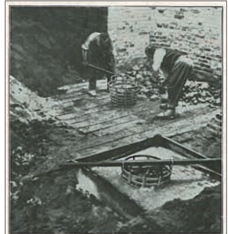
Abb. 65. Trockenlöschens durch Eintauchen in Körben. Der unruhige Wasserspiegel (vorn) zeigt, daß die Wasseraufnahme noch nicht beendet ist. Oben rechts wird ein zweiter Korb gefüllt. Links sieht man den Fuß des Löschaufens. (Nach Eisenmann, Kalklöschens, s. Abb. 62.)
