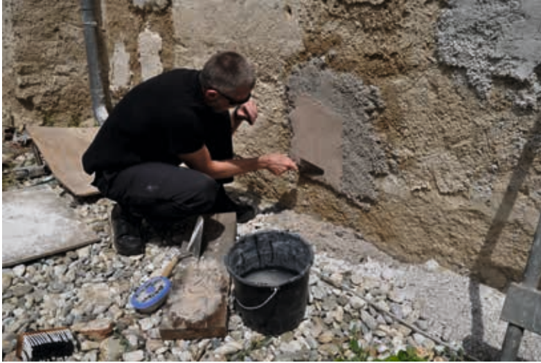
Abbildung 13: Auftragen des Korbkalks als Glätte, Mauerbach 2012 37
