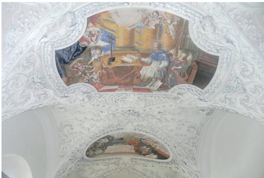
Abb. 13: Ranshofen, Gewölbe der Bibliothek des ehemaligen Klosters (2014)
