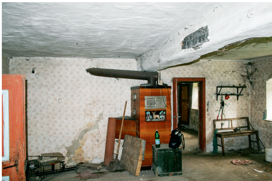
Abb. 21: Lest 11, EG2 mit Balkenunterzug von 1756.
