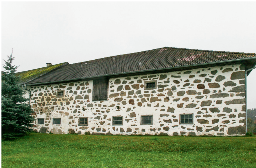
Abb. 37: Lest 13, Stall und Tennengebäude mit Ortsteinquaderung.
