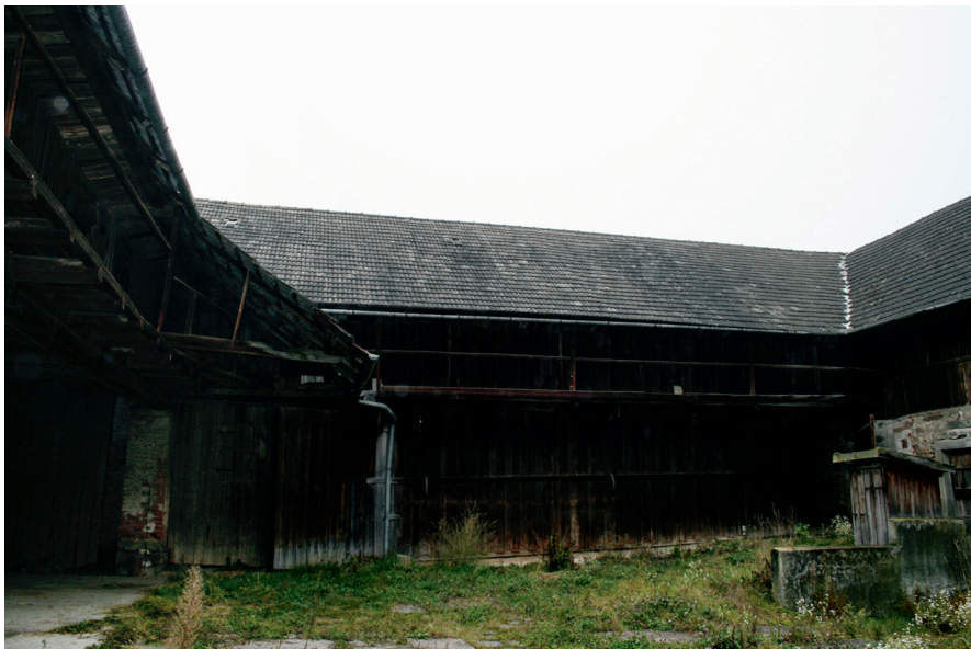
Abb. 16: Radingdorf 7, Scheune mit Schrotgang, 1899.
