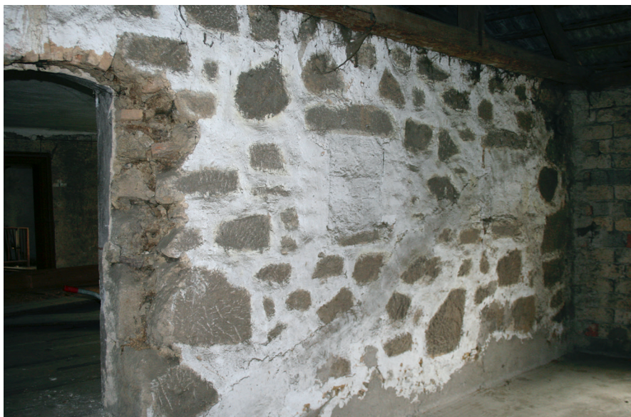
Abb. 24: Lest 11, Außenansicht der drei verfüllten Südfenster von OG2, das westlichste wurde im 20. Jh. zu einer Tür ausgebrochen.
