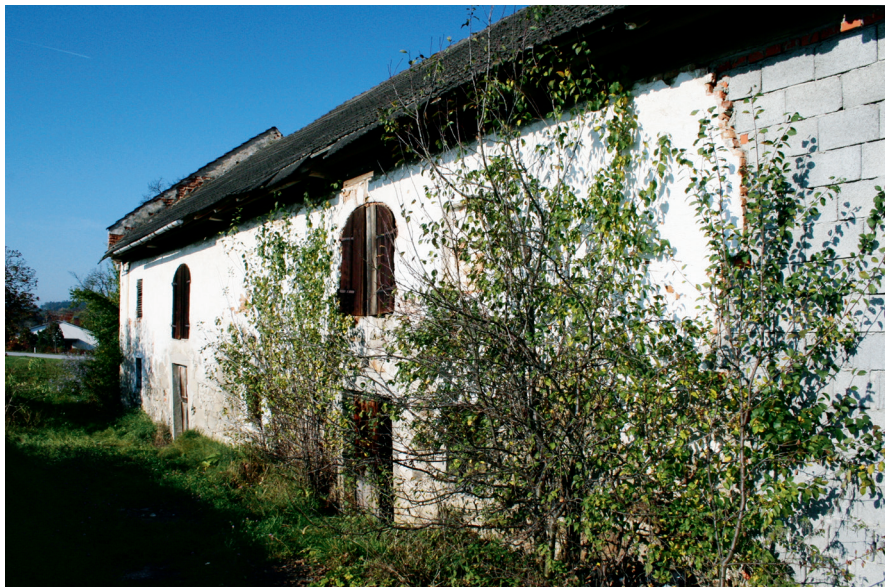
Abb. 11: Radingdorf 7, Kuhstall, Südfassade, Erdgeschoß zwischen 1843 und 1858, Obergeschoß 1899.
