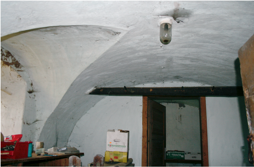
Abb. 6: Radingdorf 7, EG2, Ostmauer mit Stichkappe.
