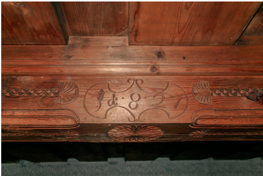
Abb. 35: Lest 13, OG2, Balkendecke, Unterzug mit Datierung 1827.
