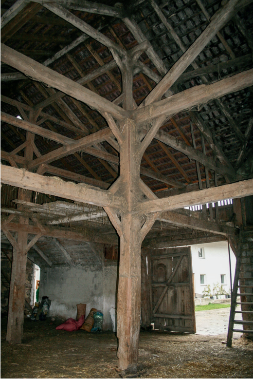
Abb. 43: Lest 13, Holzkonstruktion der Tenne mit drei Kehlbalkenlagen und Mittelsäulen.
