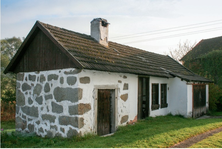
Abb. 38: Lest 13, Backhaus mit Abgang in den Most- und Erdäpfelkeller, daneben Ortsteinsetzung zum ursprünglich offenen Erdgeschossbereich.
