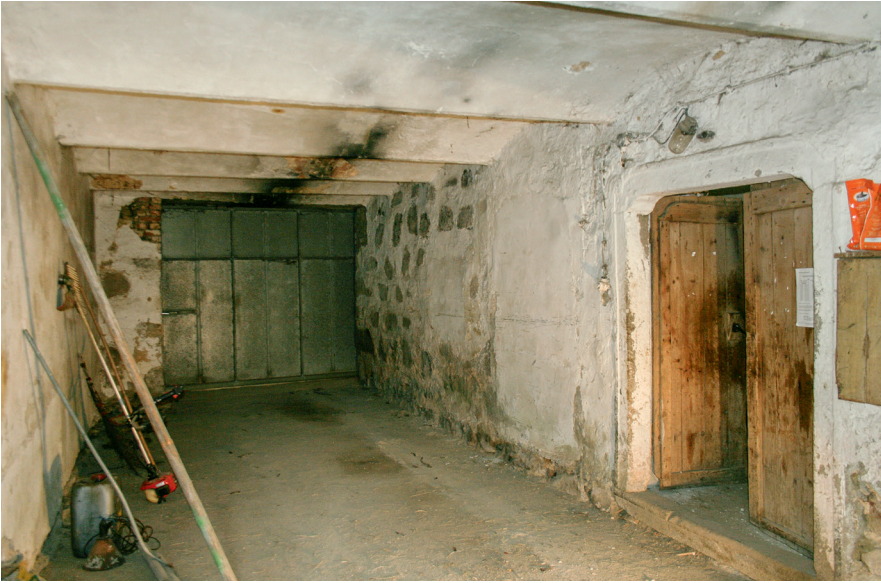
Abb. 42: Lest 13, Einfahrt EG11 mit preußischen Kappen, rechts das Portal zum Kuhstall von 1837.
