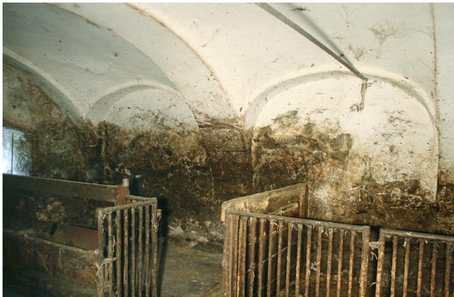
Abb. 36: Lest 13, EG8, Schweine Stall mit Platzlgewölbe.
