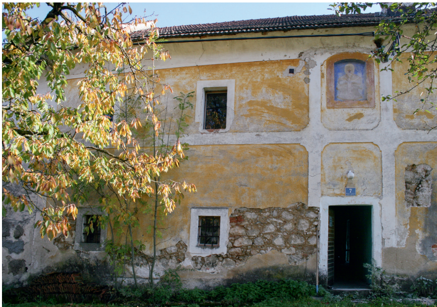
Abb. 4: Radingdorf 7, Westfassade des Kernbaus mit freigelegtem Mauerwerk, ganz rechts ist die Nordkante des ursprünglichen Zugangs zu erkennen.
