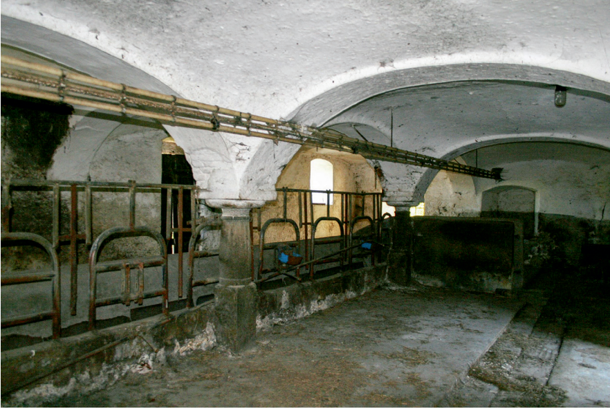
Abb. 13: Radingdorf 7, Kuhstall, platzgewölbte Säulenhalle.
