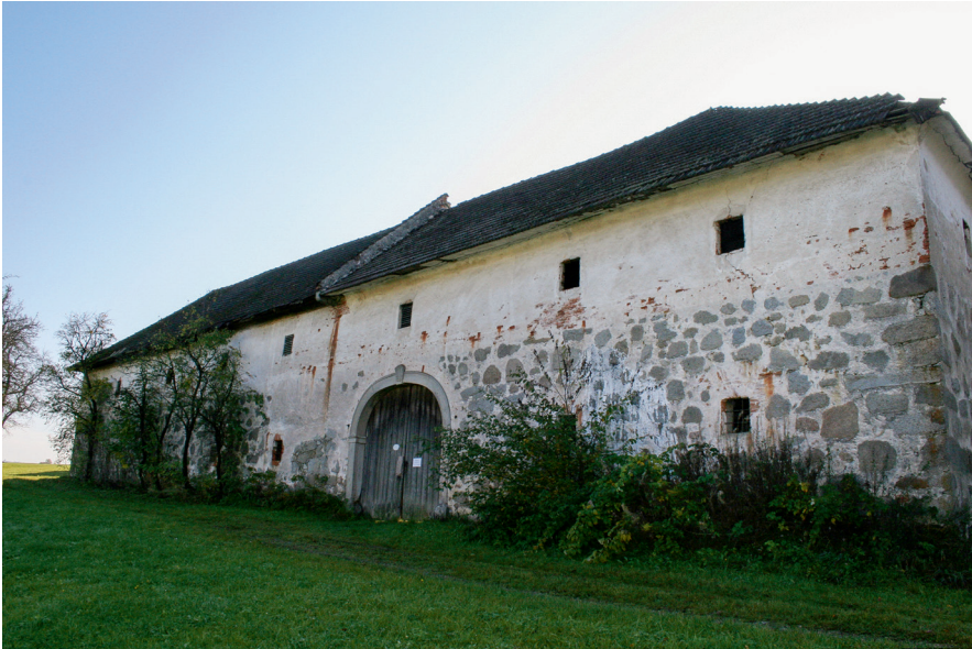
Abb. 14: Radingdorf 7, Wagenhütte und Schweinestall, Nordfassade.
