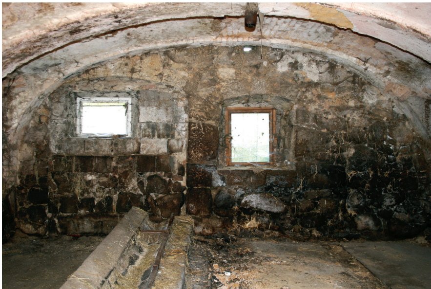
Abb. 28: Lest 11, Rinderstall EG8 mit einem primären Fenster rechts und einem zu einem Fenster nachträglich reduzierten Tor links.
