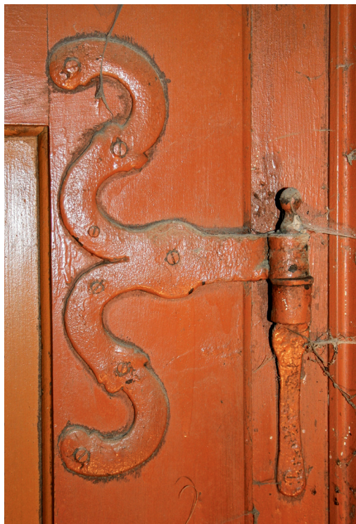
Abb. 27: Lest 11, EG2, Türbänder der Tür in der Westmauer.
