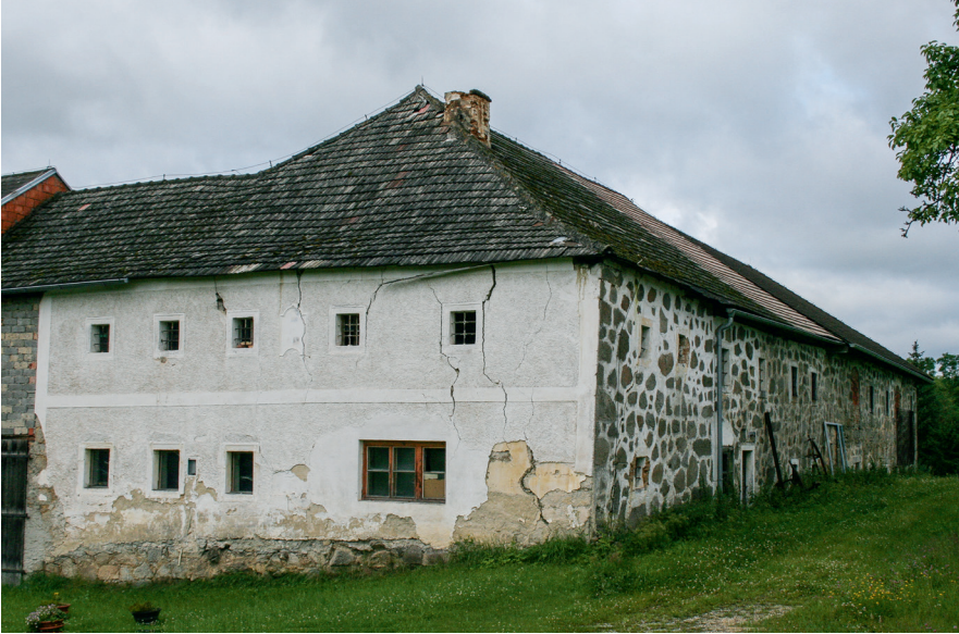
Abb. 19: Lest 11, Ansicht von Nordosten, der Kernbau reichte bis zur Ortsteinquaderung hinter der Regenrinne rechts.
