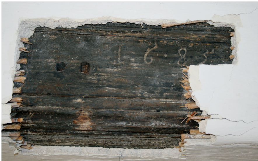
Abb. 7: Radingdorf 7, EG7, Rüstbaum mit der Datierung 1685.
