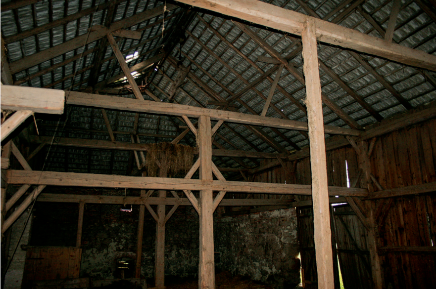
Abb. 15: Radingdorf 7, Ständerkonstruktion der Scheune, 1899.
