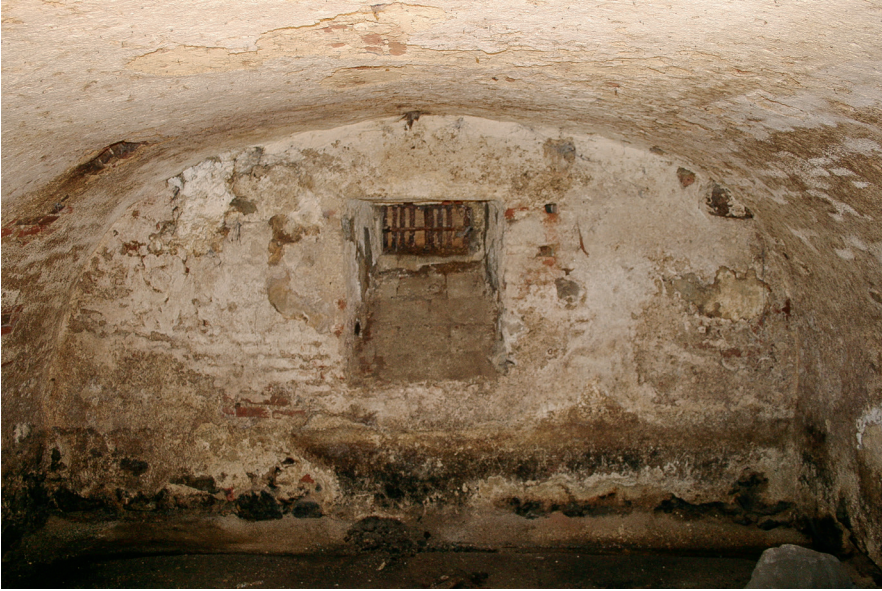
Abb. 3: Radingdorf 7, Keller mit primärem Fenster und Steckgitter in der Nordmauer, um 1580.
