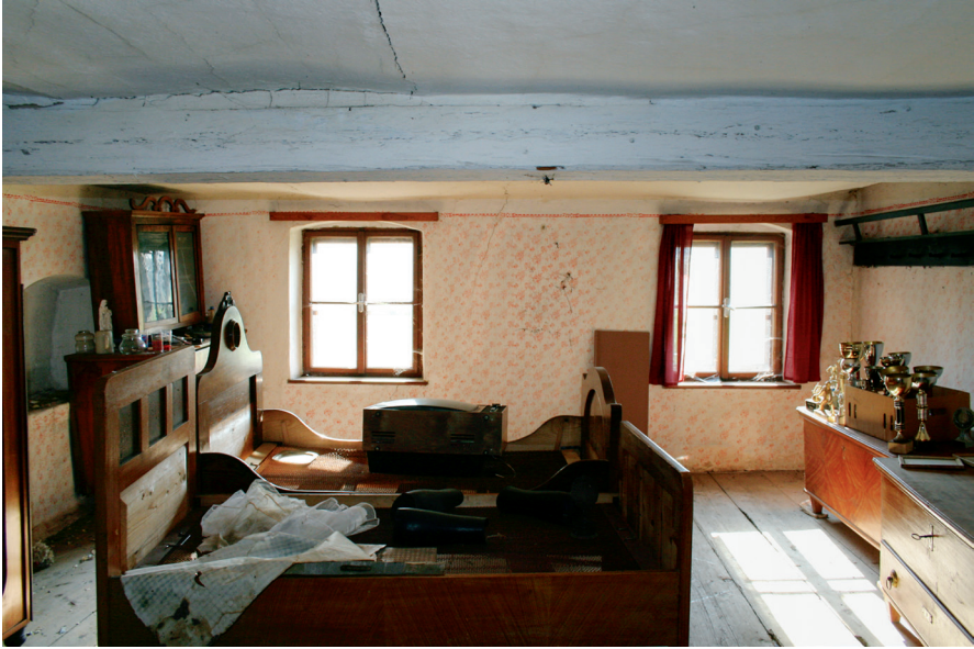
Abb. 9: Radingdorf 7, OG7, barocke Fensteröffnungen und rechts neue Zwischenwand zu OG6, um 1685.
