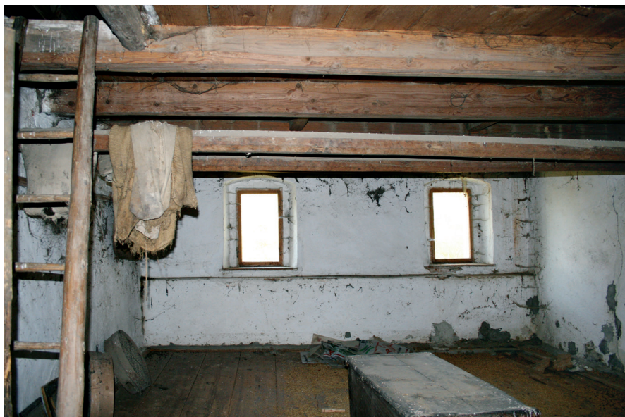
Abb. 10: Radingdorf 7, OG2/3 mit barocken Balkendecken, um 1685.
