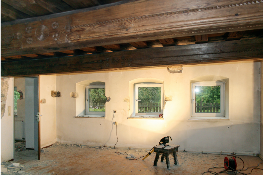
Abb. 32: Lest 13, Wohnstube EG2, Ostmauer, drei primäre Fensterleibungen.
