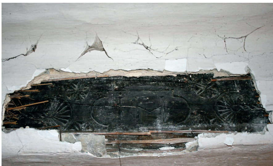
Abb. 22 und 23: Lest 11, EG2, Unterzug mit Datierung 1756 und I H.
