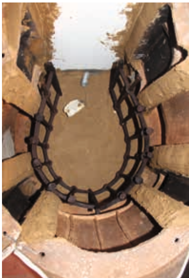
Abb. 7: Originaler Feuerkorb in einem Rokokoofen aus der Zeit um 1760 (Foto: D. Haas).
