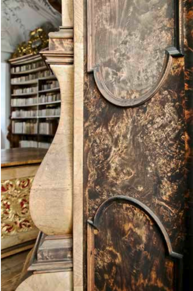
Abb. 7: Durch zu starken Lichteinfall verursachter Schaden an den Furnieren der historischen Kästen (Foto: Stefan Kerschbaumer).
