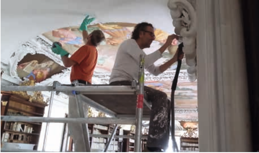
Abb. 4: Sanierungsarbeiten am Deckenfresko von Ruffini (Foto: Paulus Wall).
