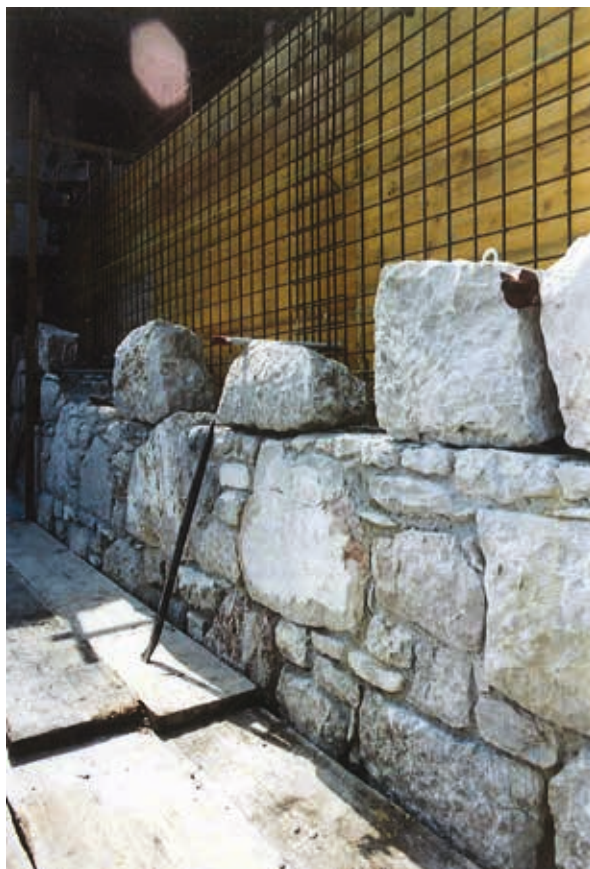
Abb. 29: Ansetzen der größeren Steine einer Schar (Foto: Idam).
