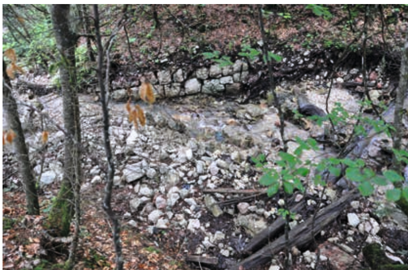
Abb. 77: Steinbergbachverbauung, Rest einer Längsverbauung, Quadermauerwerk, 1078m N47°33,925' E13°37,717' (Foto: Idam 2013).
