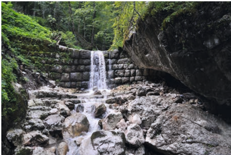
Abb. 74: Werk Nro. II „Falkenhayn-Sperre“ (Foto: Idam 2013)
