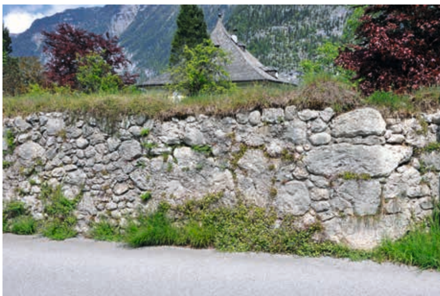
Abb. 37: Mauerkrone aus Rasensoden, Hallstatt (Foto: Idam).
