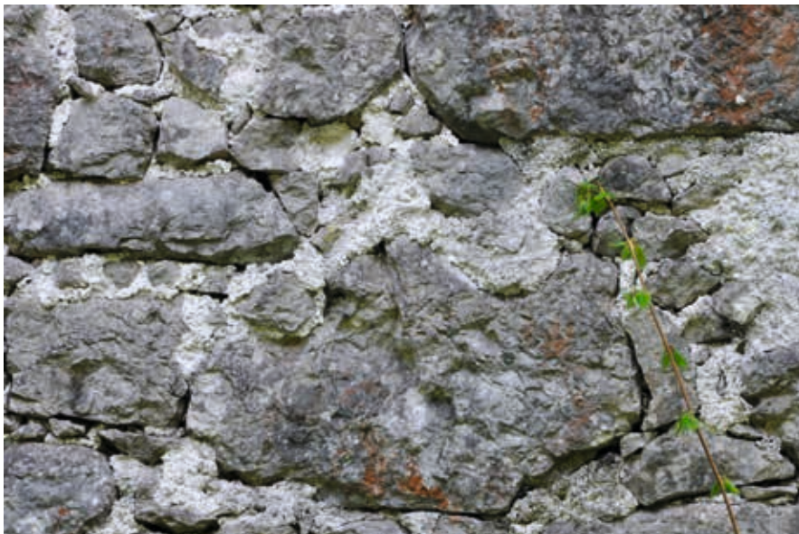
Abb. 34: Kalkmörtelfuge um 1900, durch Dachvorsprung geschützt (Foto: Idam 2014).
