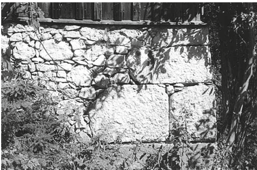
Abb. 6: Schafferstadel Salzberg, Quader- und Bruchsteinmauerwerk, 18. Jahrhundert. Auswicklungen zwischen den Eckquadern (Foto: Idam).
