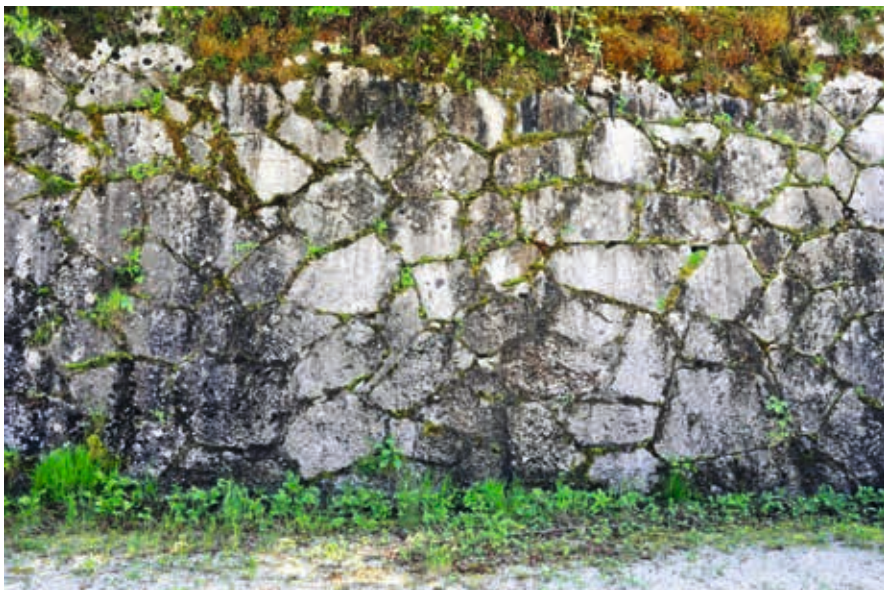
Abb. 26: Salinarische Hacklmauer (Zyklopenmauerwerk) Hallstatt (Foto: Idam).
