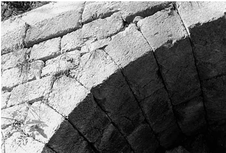
Abb. 1: Bogenbrücke Soleleitungsweg km 1.6, Quadermauerwerk (Foto: Idam 2001).
