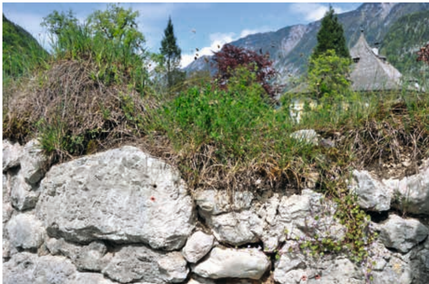
Abb. 38: Mauerkrone aus Rasensoden, Detail, Hallstatt (Foto: Idam).
