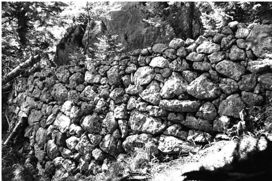
Abb. 24: Zugweg Kreuzberg Ostflanke, Trockenmauerwerk, 19. Jahrhundert (Foto: Idam).
