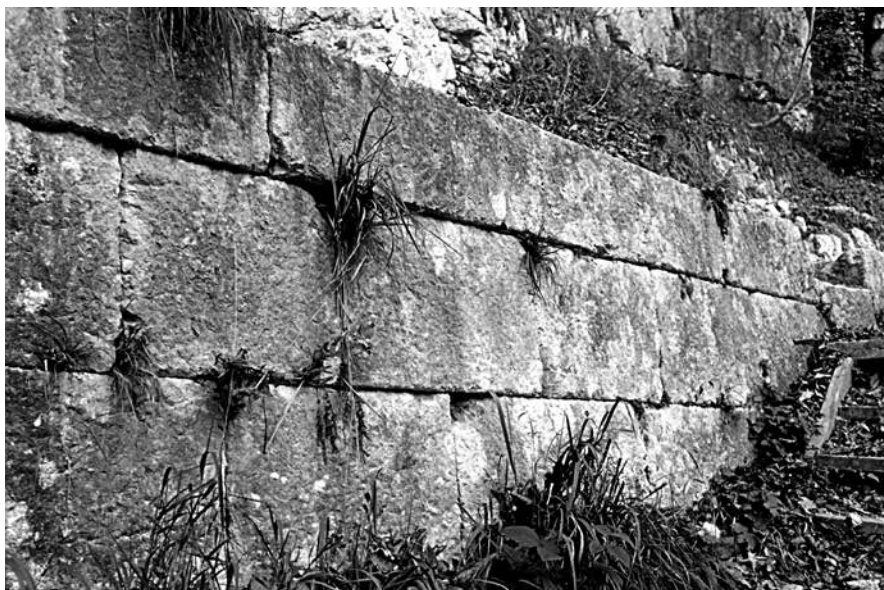
Abb. 25: Salinarische Quadermauer, Soleleitungsweg Hallstatt (Foto: Idam).
