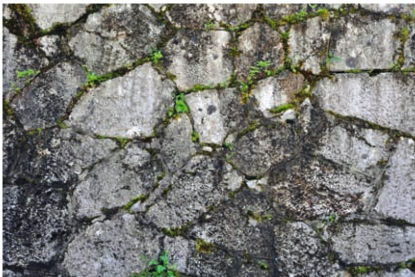
Abb. 27: Hacklmauer (Zyklopenmauerwerk), Detail, Hallstatt (Foto: Idam).
