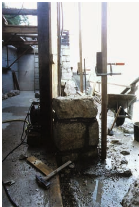
Abb. 28: Latten-Schnurgerüst, im Vordergrund ein Meißelhammer (Foto: Idam).
