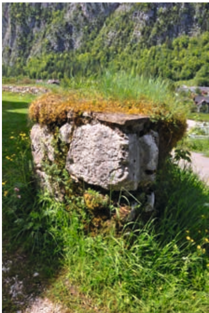
Abb. 7: Brüstungsmauer Hallstatt, Kalvarienberg (Foto: Idam 2014).
