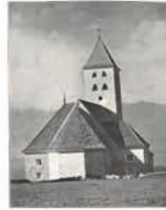
Abb. 12. Moderne Kirchenbau: St. Barbara in Pöchlarn (Prof. H. Holzmeister).
