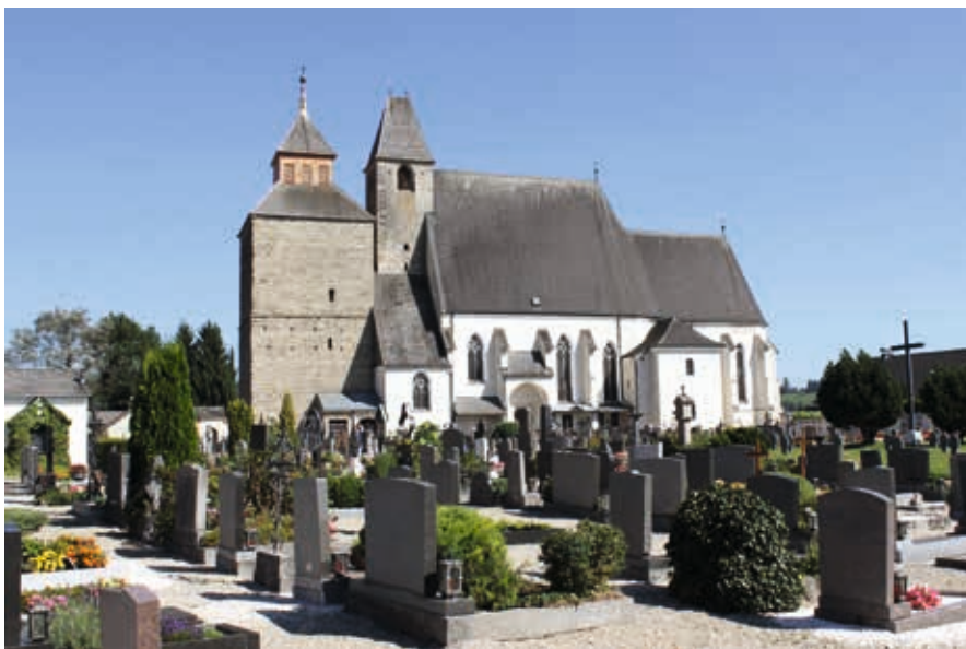
Abb. 3: Kirche Maria Schöndorf, spätgotische Hallenkirche, Attergauer Bauhütte, 15. Jahrhundert
