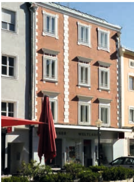
Abb. 21: Haus Stadtplatz 23, Fassade 18. Jh., Kernmauerwerk und Tonnengewölbe 2. Hälfte 16. Jahrhundert.
