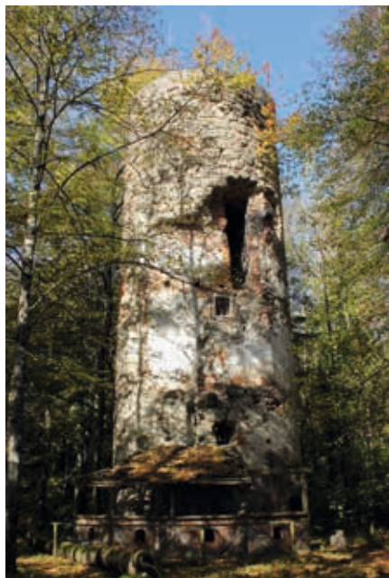
Abb. 15: Ruine Wartenburg, Reste des Bergfrieds mit Einstiegs Luke, Rundbau aus Steinquadermauerwerk
