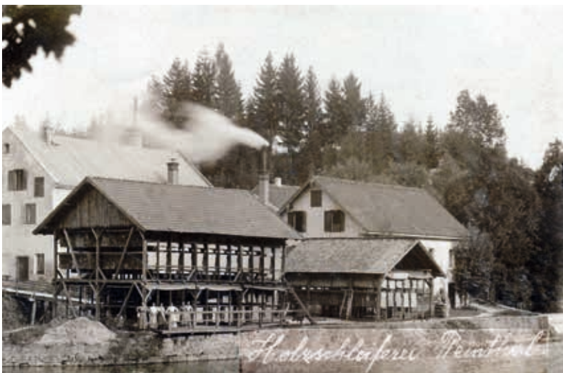
Abb. 15: Die Tonwarenfabrik Reinthal wurde 1866 in eine Holzschleiferei umgebaut. Foto des Gebäudebestandes um 1900 (Sammlung P. Huemer, Laakirchen).
