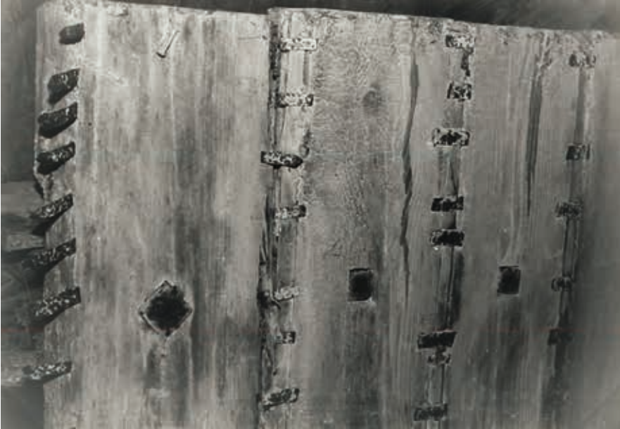
Abb. 6: Ackerklause. Detail des Schlagtor-Flügels mit der Abdichtung der Stoßfugen. Sichtbar sind hier die Dreikantleisten (genannt ‚Zaine‘), welche durch eiserne Klammern (genannt Klumperl) gehalten werden. Zustand 1986 (Foto: Franz Federspiel).
