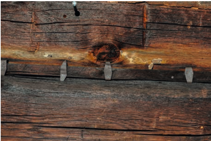
Abb. 9: Wimmeralmhütte auf der Zimnitz, Bad Ischl. Detail der Abdichtung der Fugen. Zustand 2017 (Foto: Thomas Nussbaumer).
