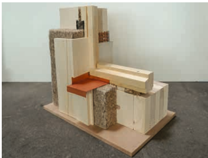
Abb. 12: Modell einer massiven Holzwand mit Fenster, die Montagefuge ist mit Torfmoos abgedichtet (Foto: Angelika Wimmer).
