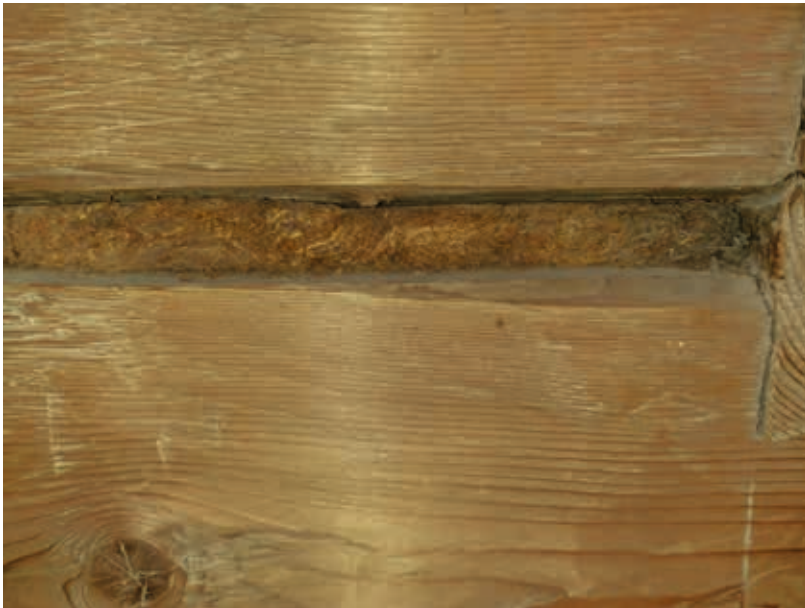
Abb. 5: Beringstadel, Gosau, Blockzimmerung 18. Jahrhundert. Dichtungsschnur aus Sphagnum. Zustand 2017 (Foto: Stefanie Mandl).
