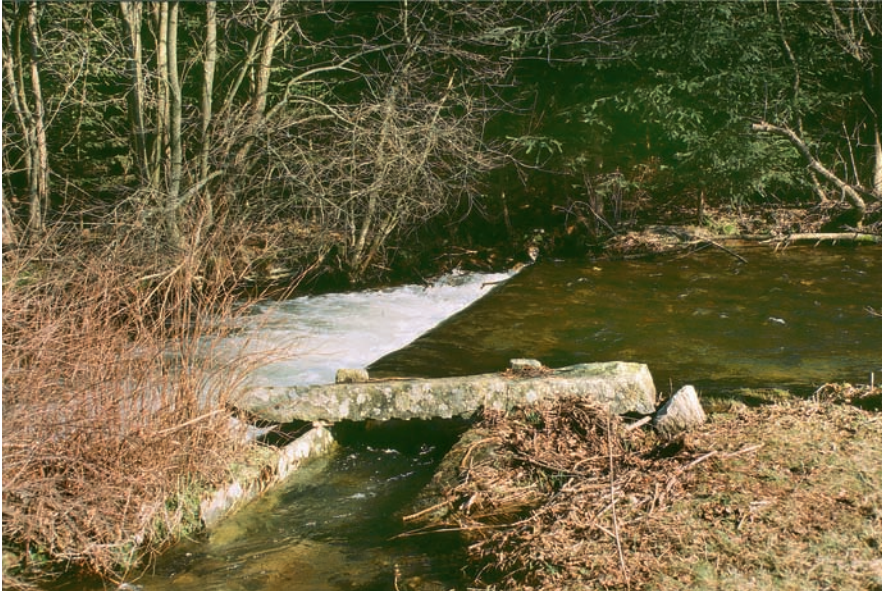
Abb. 6: Ausleitung aus dem Klafferbach kurz vor der Einmündung in die Große Mühl. Der Schwellbaum quer im Gewässerbett lässt den Bach „anschwellen“ und durch die geöffnete Ausleitung Wasser entnehmen (Foto: Karl Zimmerhackl).
