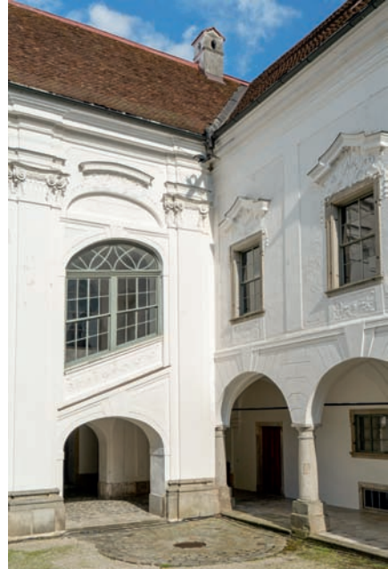
Abb. 20: Tillysburg, Südostecke im Innenhof des Schlosses.
