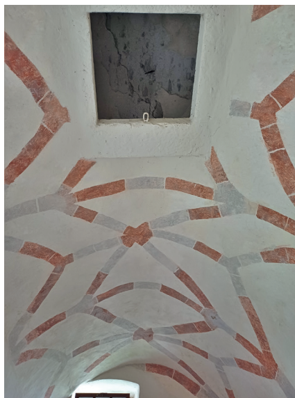
Abb. 7: Zettwing, Pfarrkirche, Sakristei, Tonnengewölbe mit gemaltem Rippennetz.
