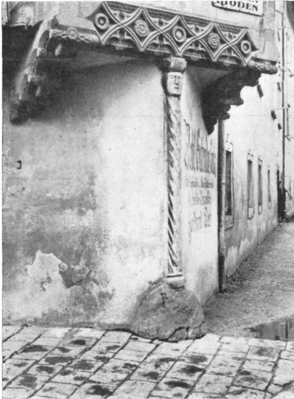
Abb. 5. Ecke des Hauses Wels, Stadtplatz 24.
