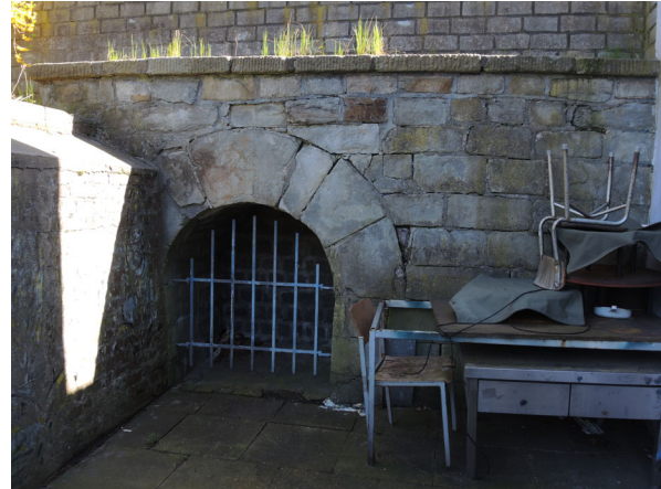
Abb. 7: Restauriertes Stollenmundloch von General Nr. 5 (T. KASIELKE).
