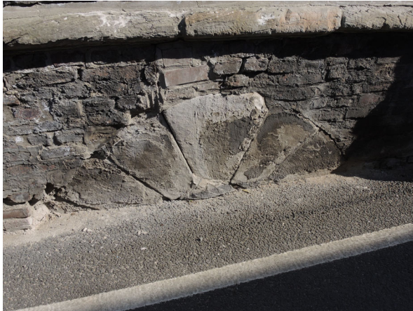
Abb. 6: Stollenmundloch von General Nr. 2 (T. KASIELKE).
