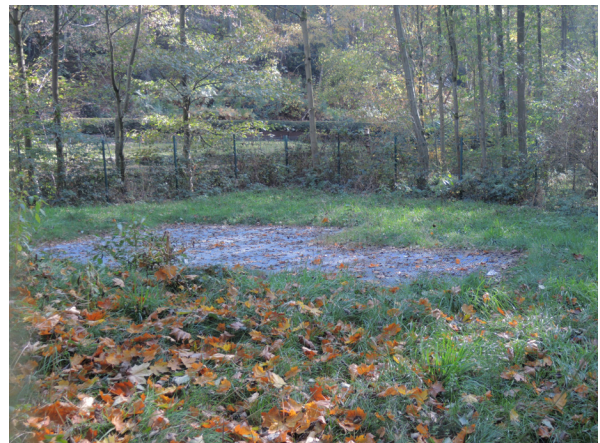
Abb. 12: Abgedeckter und eingezäunter Schacht Dreckbank (T. KASIELKE).
