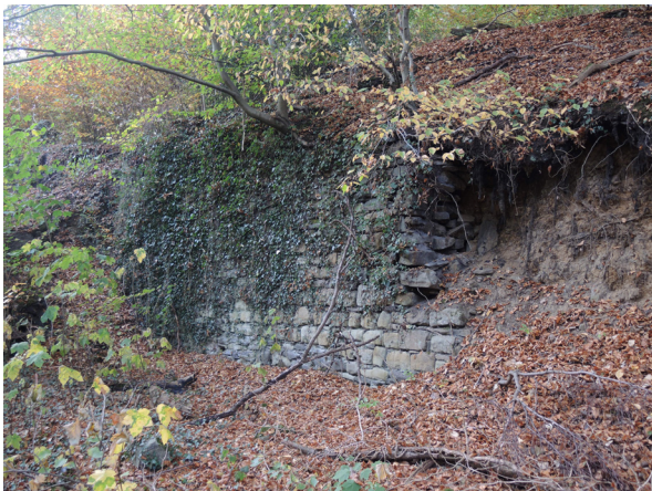
Abb. 13: Mauerreste der Zeche Kaiserin Augusta (T. KASIELKE).
