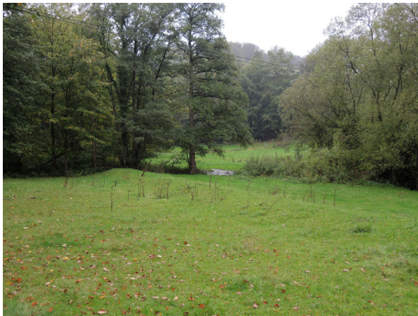
Abb. 3: Damm der alten Schmalspurbahn im Hespertal an der ehemaligen Bläufabrik (T. KASIELKE).
