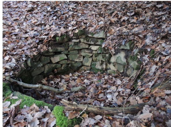
Abb. 17: Mit Bruchsteinen ausgemauertes Schacht der kleinen Eisensteinzeche Regina (T. Kasielke).
