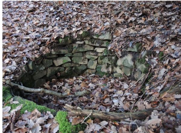
Abb. 17: Mit Bruchsteinen ausgemauerter Schacht der kleinen Eisensteinzeche Regina (T. Kasielke).
