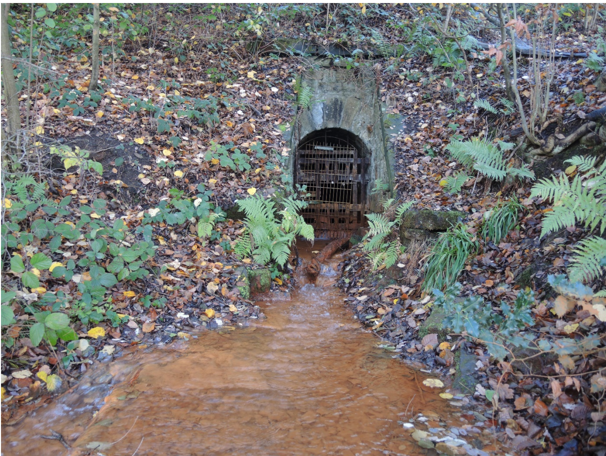
Abb. 7: Rostfarbene Ausfällungen von Eisenhydroxid vor dem Mundloch des St. Johannes Erbstollens (T. Kasielke).
