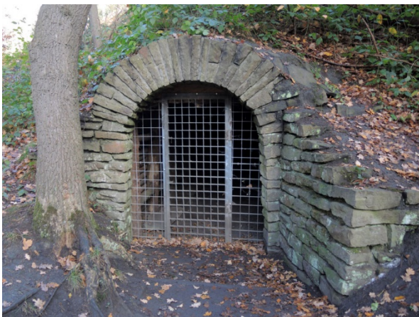
Abb. 8: Rekonstruiertes Mundloch der Zeche Reiger (T. Kasielke).
