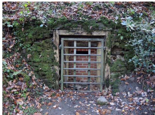
Abb. 9: Restauriertes Mundloch des westlichen Tagetriebs von Zeche Frielinghaus (T. Kasielke).
