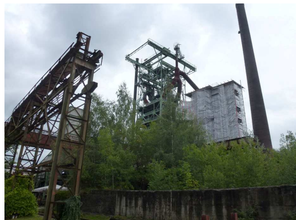
Abb. 2: Industrieruinen auf dem Gelände (A. HÖGGEMEIER).
