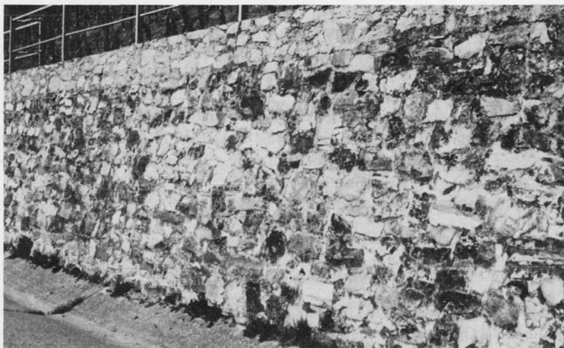
Abb. 2: Mauer eines flurbereinigten Weinberges bei Lorch.
