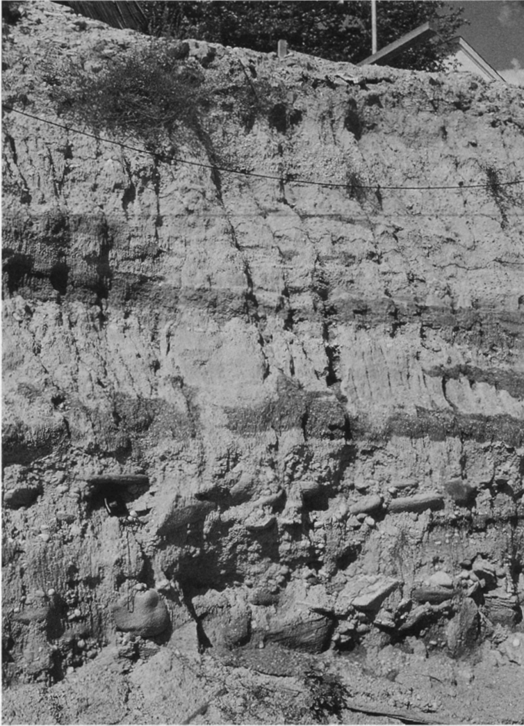
Abbildung 10: Aufschlusswand der Baugrube Idsteiner/Ecke Schumannstraße Am Fuß des Profils ist das Basiskonglomerat der Tertiär-Transgression zu erkennen. Nach oben nehmen die Korngrößen deutlich ab. (Foto vom Juli 1970)
