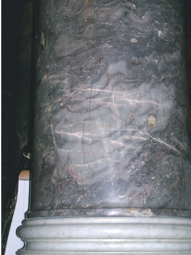
Abbildung 6: Anschnitt einer Stromatopore in einer Säule aus Lahnmarmor im Friedrich von Thiersch-Saal des Wiesbadener Kurhauses.
