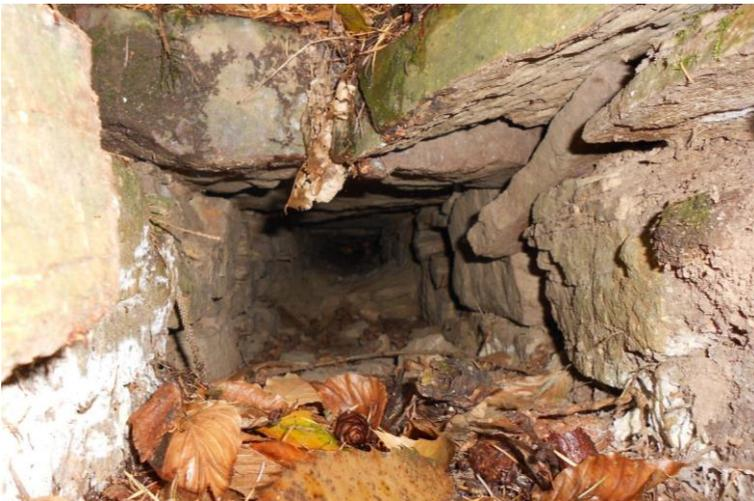
Abbildung 11: Aus Naturstein gesetzter Kanal kreuzt und unterläuft die Trasse der Nassauischen Wasserleitung. Vermutlich handelt es sich um einen römischen Zulaufkanal zum Hauptsammler; Foto: Verfasser.
