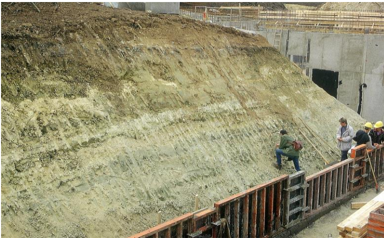
Abbildung 2: Südwand einer Baugrube im Kalktertiär im Gebiet Hildastraße.
