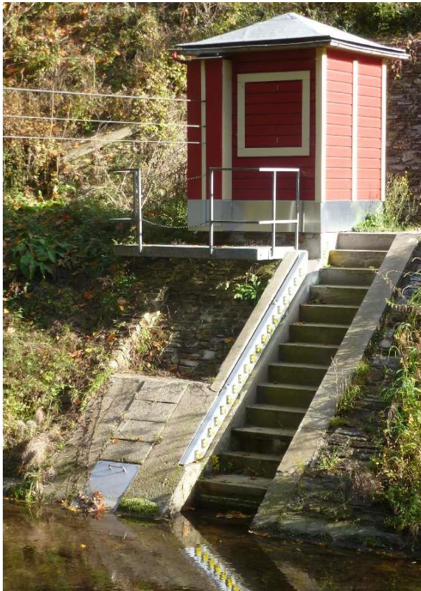
Abbildung 4: Pegel Lorch-Pfaffental (Messstellenummer: 25650156; Gauß-Krüger-Koordinaten: R 341760, H 554686; Pegelnullpunkt: 102,04 m ü. NN; Lage: 4,5 km links oberhalb der Mündung der Wisper in den Rhein; Fläche oberirdisches Einzugsgebiet: 170,40 km 2 ).
