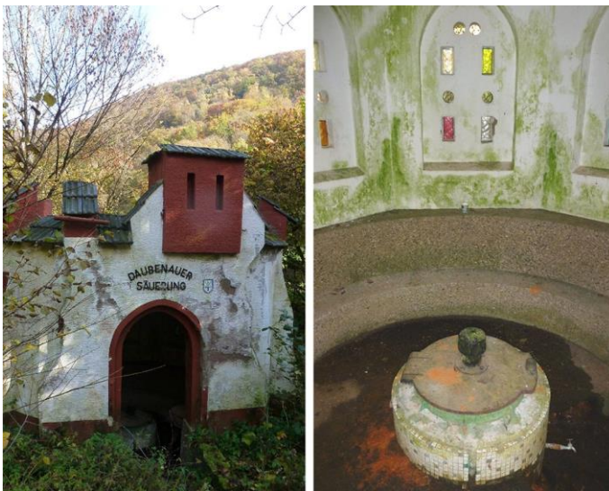
Abbildung 16a, b: a) Daubenaauer Sauerbrunnen neben der Wisper, Fassung um 1920; b) aus dem Wasserhahn tröpfelt eisenreiches Wasser, im Kontakt mit Luftsauerstoff kommt es zur Ausfällung von Fe-Hydroxid.
