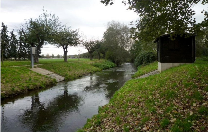
Abbildung 11: Pegel Friedberg / Usa, Außenansicht mit Pegelhaus und Seilkrananlage; Foto: HLUG.
