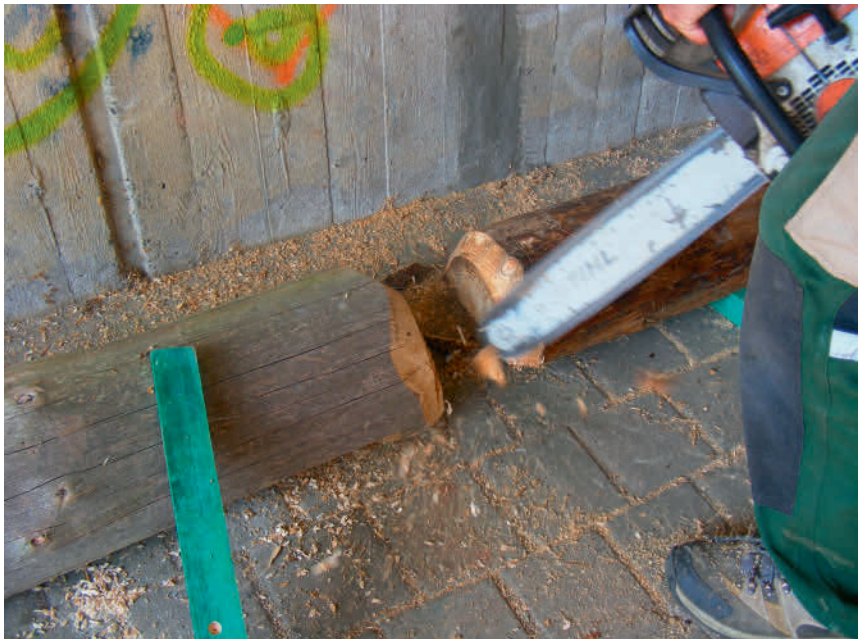
Abbildung 8: Querungshilfe im Bau; Foto: Verfasser.
