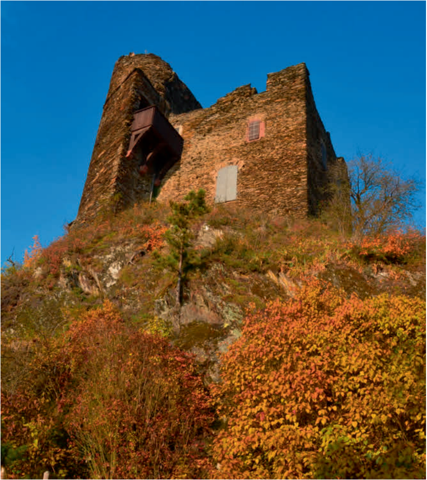
Abbildung 1: Die Höhenburg Nollig, um 1300 auf dem gleichnamigen Berg als Teil der Stadtbefestigung errichtet, war ursprünglich ein Fachwerkbau, der später mit einer massiven Mauer aus Bruchsteinen ummantelt wurde; Foto: Verfasser.
