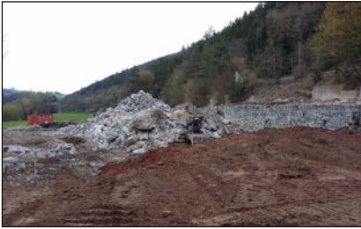
Abbildung 3: Beton wird gebrochen. Figure 3: Concrete is broken.
