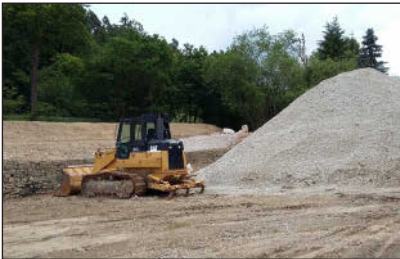
Abbildung 5 (links): Das Gelände wird planiert. Figure 5 (left): The area is leveled.
